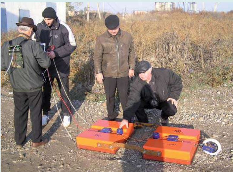
Изучение грунтов с помощью георадара при восстановлении г. Грозного, 2006 г.
